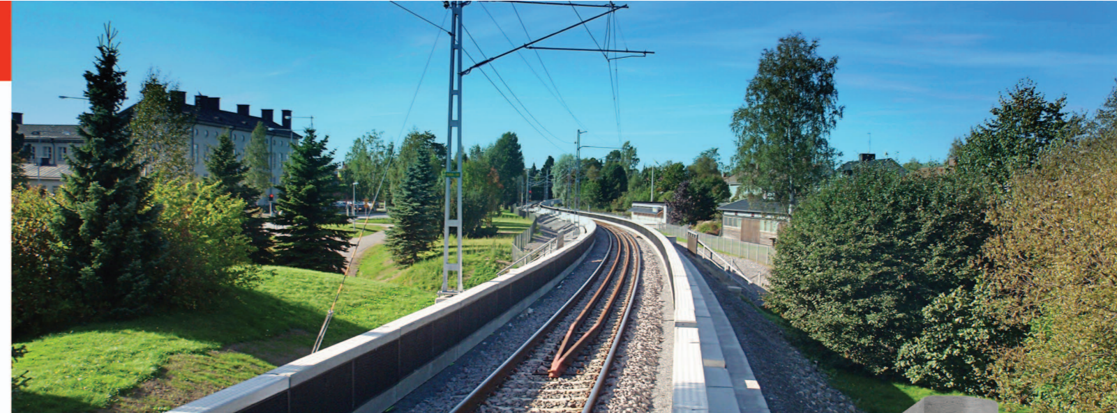
SKOGÅS, SCHWEDEN Einsatz von Zbloc zur Einhaltung des zulässigen Lärmpegels für die Genehmigung des Baus einer Schule.
