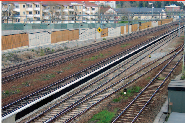
RITORP, SCHWEDEN Ergänzung einer vorhandenen herkömmlichen Schallschutzwand mit Zbloc, da für die Bewohner höher liegender Wohnungen der Lärmpegel nicht reduziert werden konnte.
