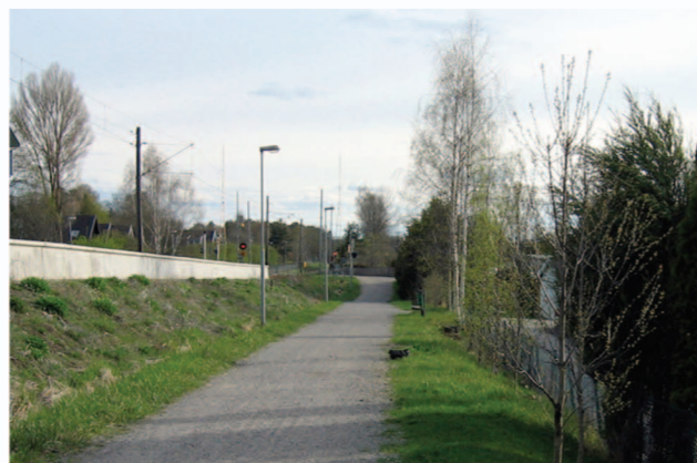
TÄBY KYRKBY, SCHWEDEN Einsatz von Zbloc im Wohngebiet, ohne dieses durch eine hohe Wand optisch zu teilen. Der Sichtkontakt der Anwohner bleibt erhalten. Unterhaltungen auf dem neben der Trasse liegenden Gehweg bleiben trotz Zugverkehr möglich.
