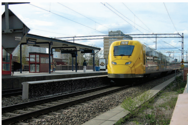
SOLLENTUNA BAHNHOF, SCHWEDEN Schalldämpfung durch Zbloc für die Durchfahrt des Arlanda Express mit 170km/h.
